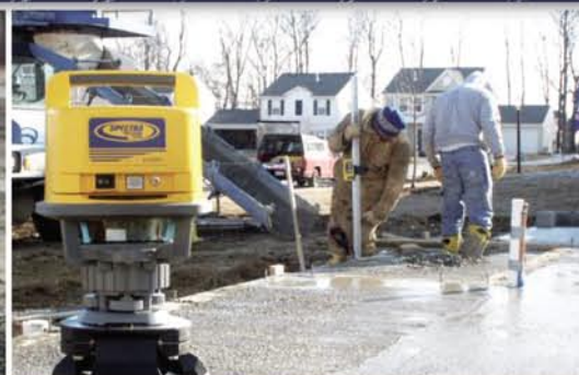
ЗАЛИВКА БЕТОНА | LL400, LL500 | СТР. 5
